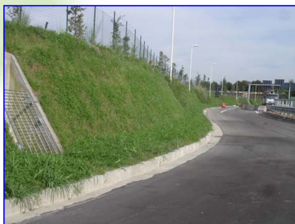
Foto 5 – Realizzazione di uno svincolo di uscita presso la tangenziale sud di Parma con Sistema FAST-TER ®
