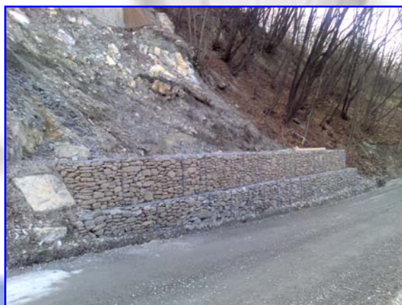
Foto 4 – Gabbionata chiodata a fine lavori
