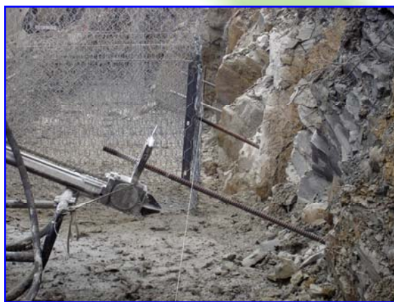
Foto 3 – Realizzazione della chiodature
