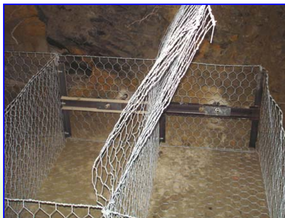
Foto 1 – Fasi costruttive prima del riempimento del gabbione
