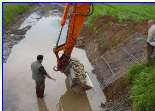
Foto 2 – Fasi di posa in opera, riempimento delle tasche "idrauliche" con ciottoli
