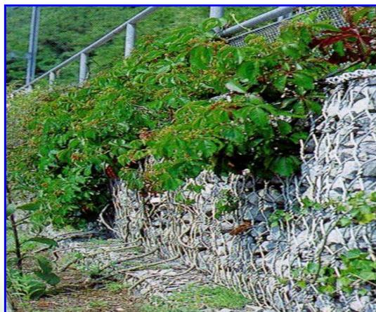
*Foto 1 – Muro di sottoscarpa in gabbioni*
