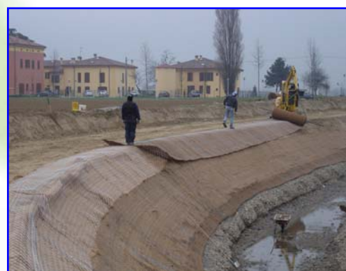
Foto 6 – Realizzazione dei materassi e stesa del geocomposito
