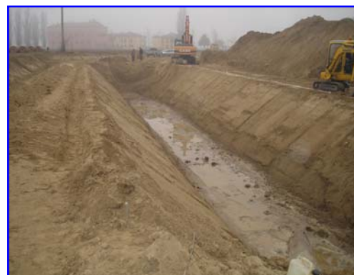
Foto 5 – Interventi tipo schema fig.1 – inizio lavori
