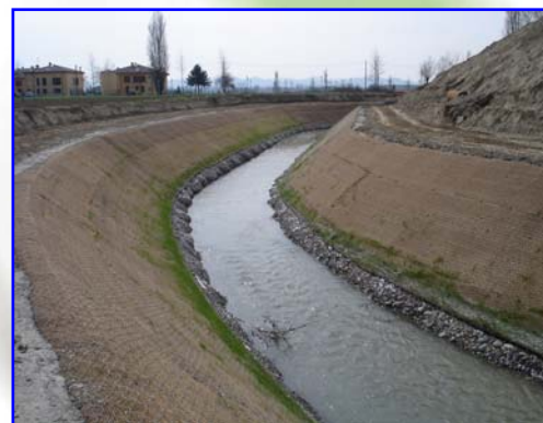
Foto 7 – Situazione a fine lavori
