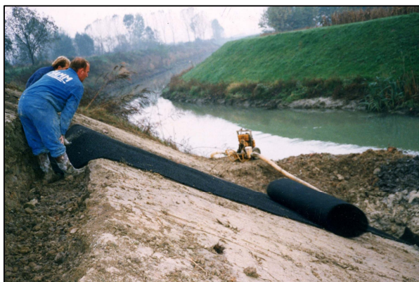
Srotolamento di EROLAND su sponda di canale
