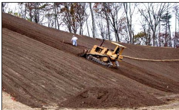
Stesura di materiali di riempimento con mezzi meccanici
