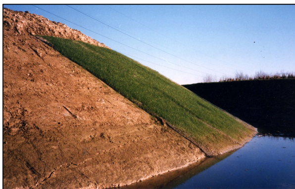
Intervento con EROLAND per inerbamento antierosivo di sponda
